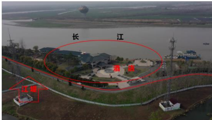
图1 2022年3月27日，督察组现场督察发现，扬中市西沙湾星空酒店违法建设在长江河道内
